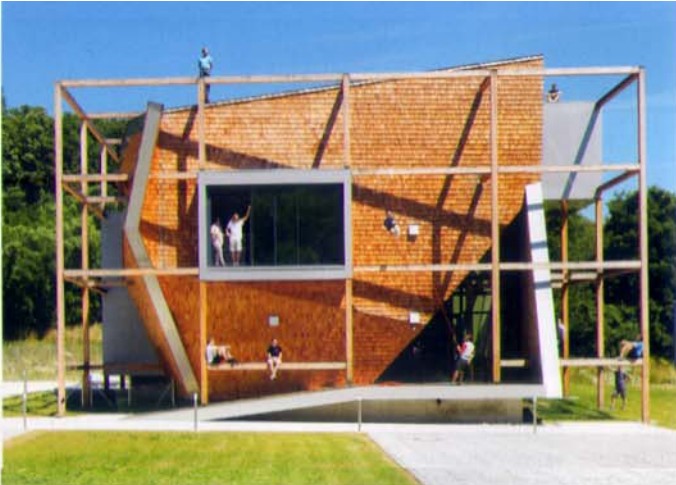
OFFICE OFF, 2013 – Ein unkonventionelles Holz-Bürohaus im Burgenland. Eine komprimierte Klimahülle in einer räumlichen Rasterstruktur. Innen und außen gibt es Kletterwände und -Konstruktionen.
